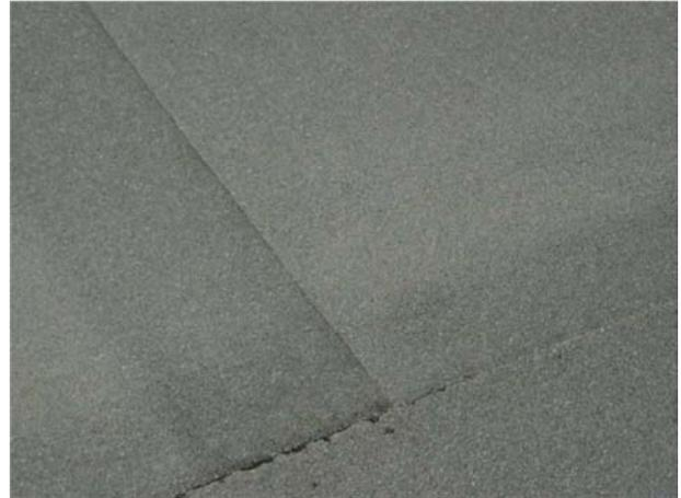
Aspecto de los solapes transversales y longitudinales de la lámina superior de una cubierta autoprotegida.
