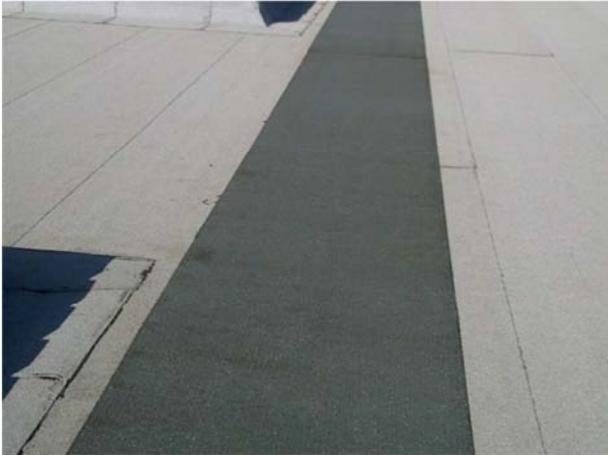
Detalle de un pasillo de mantenimiento soldado a la impermeabilización autoprottegida ESTERDAN PLUS 50/GP PASILLOS TECNICOS.
