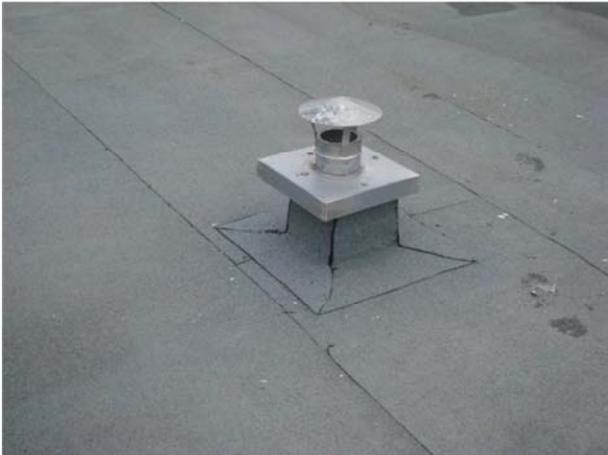
Paso de conductos de ventilación mediante pasatubos.
