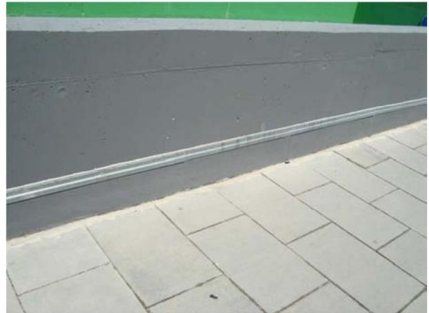
Remate de la impermeabilización contra un peto con una altura correcta. El perfil de remate está bien instalado y sellado superiormente.
