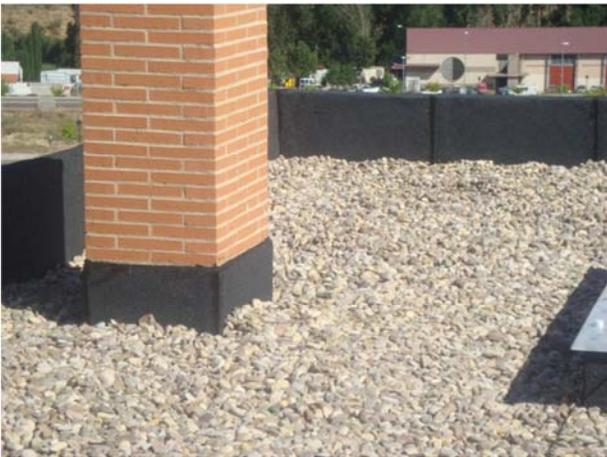
Verificación del espesor uniforme de la capa de grava.
