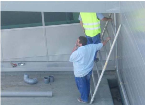
Trabajos en zonas adyacentes a la cubierta pueden ocasionar desperfectos en la misma, sobre todo en el caso de cubiertas autoprotegidas.
