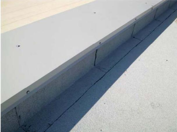
Albardilla metálica en un peto bajo de una cubierta deck.
