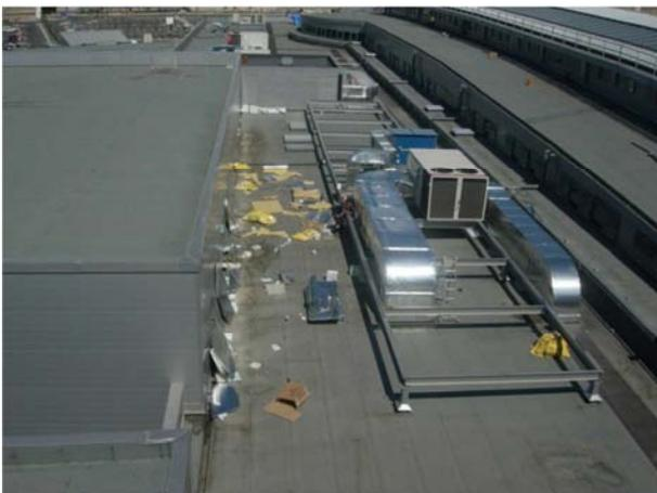
La instalación de equipos en la cubierta puede ocasionar graves daños en nuestro sistema de impermeabilización.
