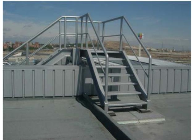
Apoyo de escalera metálica mediante elementos de refuerzo para evitar daños en la membrana impermeabilizante.
