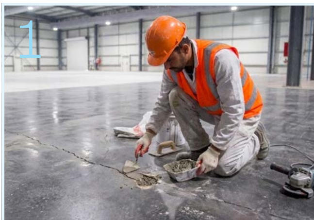
1 > Reparación del sustrato
