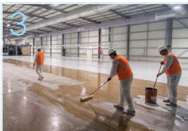
3 > Aplicación de la imprimación
