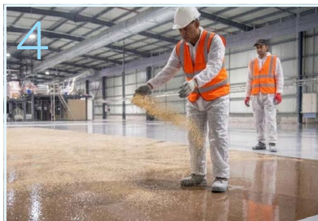
4 > Espolvorear la imprimación con árido de sílice
