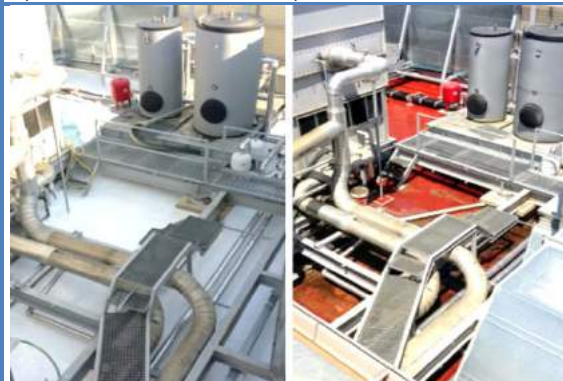
NTV9. Cubierta técnica plana no transitable. SRI 106. Edificio MAPFRE, Madrid. (España)
