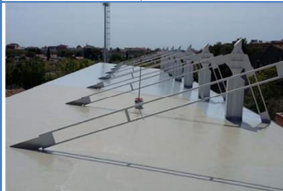
NTV8. Cubierta plana no transitable. Tribuna Campo de futbol de Calafell. Tarragona (España)
