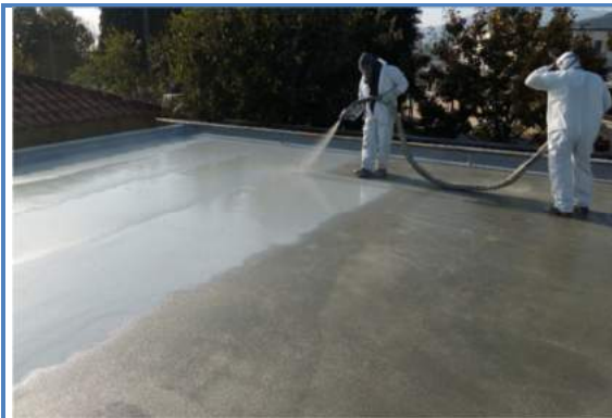
NTV8. Cubierta plana no transitable. Hospital Conde Bertiandos. Ponte de Lima (Portugal)
