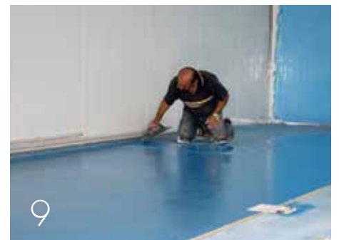
CAPA FINAL DE REVESTIMIENTO
