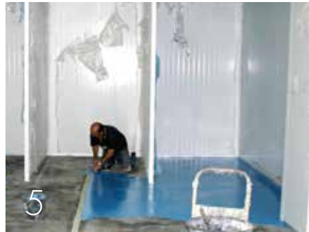
APLICACIÓN DE LA PRIMERA CAPA
