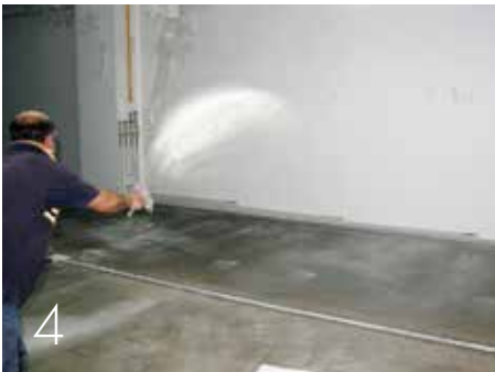
ESPOLVOREAR LA IMPRIMACIÓN CON ÁRIDO DE SÍLICE
