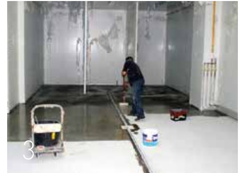
APLICACIÓN DE LA IMPRIMACIÓN
