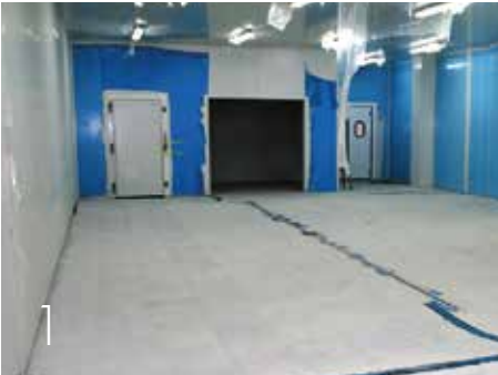
REPARACIÓN DEL HORMIGÓN
