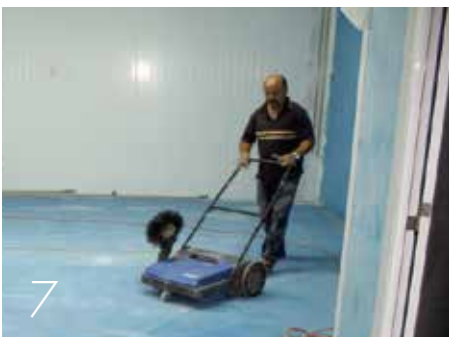
RETIRA EL EXCESO DE ÁRIDO DE SÍLICE
