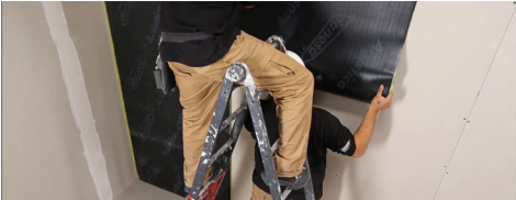
PUESTA EN OBRA BÁSICA (FUJADA MECÁNICAMENTE)
