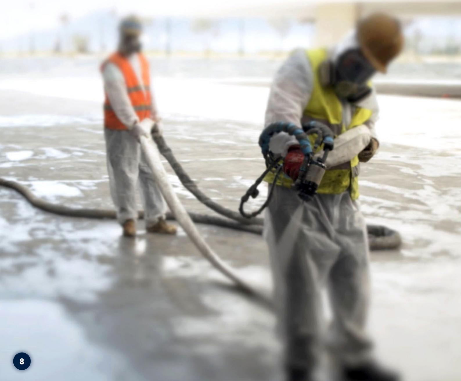
Las imprimaciones tienen la función de preparar y sellar el soporte y mejorar la adherencia de la membrana impermeabilizante. Se seleccionan en función del tipo de soporte, de su porosidad, de las condiciones ambientales durante la aplicación y curado.
