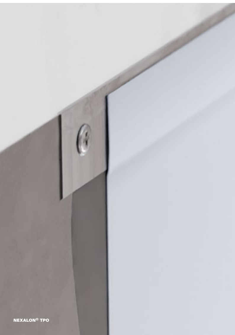
Fig 1.: Fijación con perfil colaminado A-TPO
