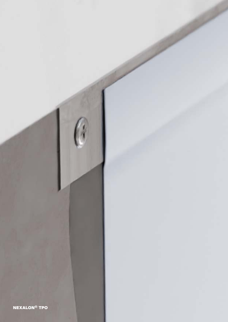
Fig 1.: Fijación con perfil colaminado A-TPO
