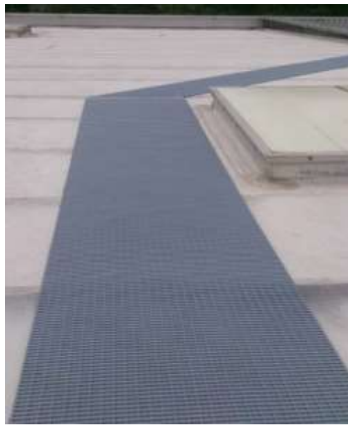
Figure 23 - Mise en place du DANOGRID PVC
