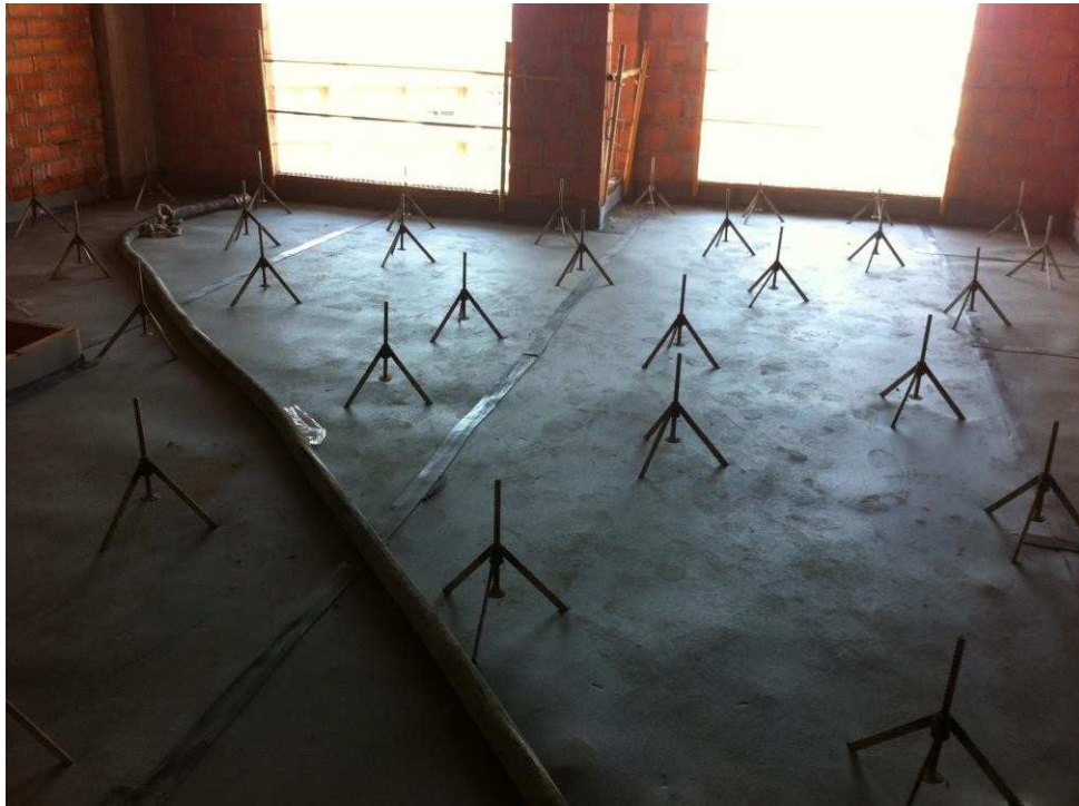
Photographie 1 : Placement général. Prêt pour le déversement de mortier.
