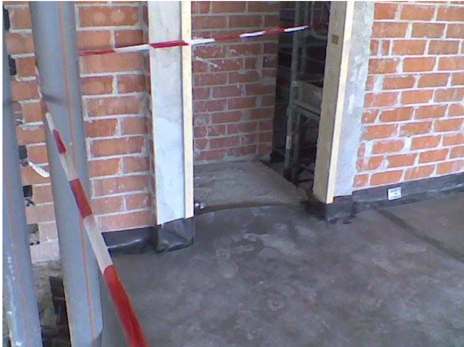
Photographie 2 : Protection des précadres et aspect général du recouvrement vertical.
