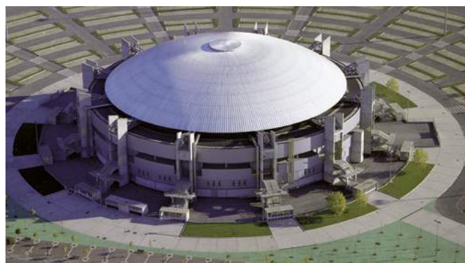
PABELLÓN ARABA. Espanha.
