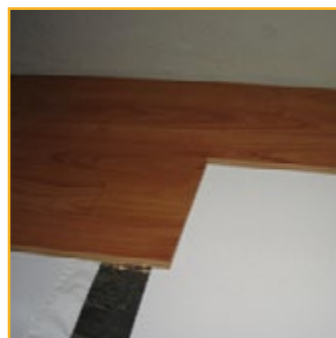
Fita de alumínio para eliminar a electricidade estática
