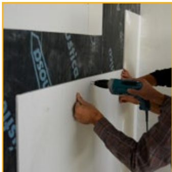
Coloque a segunda placa (parede)
