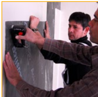
Grampo em primeira placa (parede)
