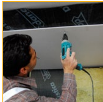
Coloque a segunda placa (teto flutuante)
