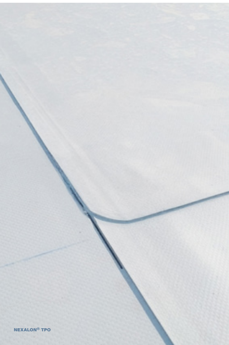
Encontro em T entre três membranas
